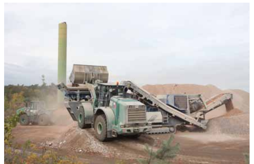
Das Abbruchmaterial wird getrennt in Beton und Rotstein als neue Gesteinskörnung mittels Brech- und Siebanlage so aufbereitet, dass es etwa im Straßenbau als Tragschichtmaterial wiederverwendet werden kann.
