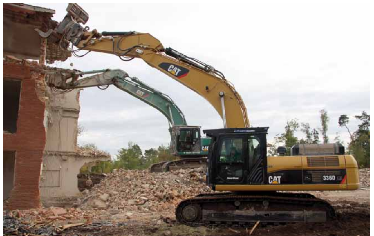
Erst krallen sich die Bagger im Gebäude fest, dann rütteln und zerren sie daran und bringen Bruchstücke kontrolliert zu Boden.
