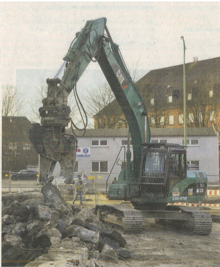
Die alte GTV-Halle an der Elbestraße ist abgerissen. Die Stadt scheute sich vor den Sanierungskosten.
